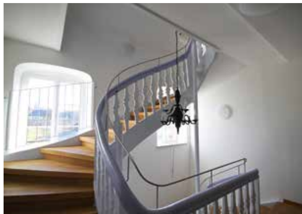
Treppenaufgang zur AWO-Mittagsbetreuung im Rathaus-Mittelbau
