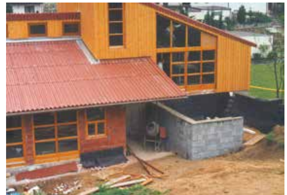
Kindergarten-Neubau: Richtfest nach nur vier Monaten Bauzeit im März 1984
