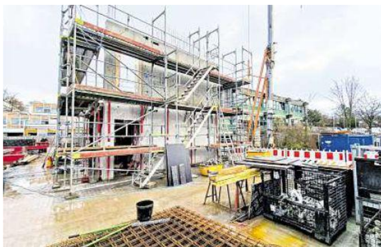
Noch nicht ganz fertig ist das Treppenhaus mit Aufzugschacht, das derzeit noch von der Rohbaufirma dreigeschossig auf der Bodenplatte über dem Untergeschoss in Stahlbeton errichtet wird.
